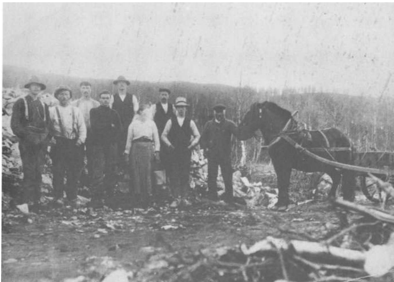
Vegarbeid omkring 1918/20 ved Storli (Rokstad).
