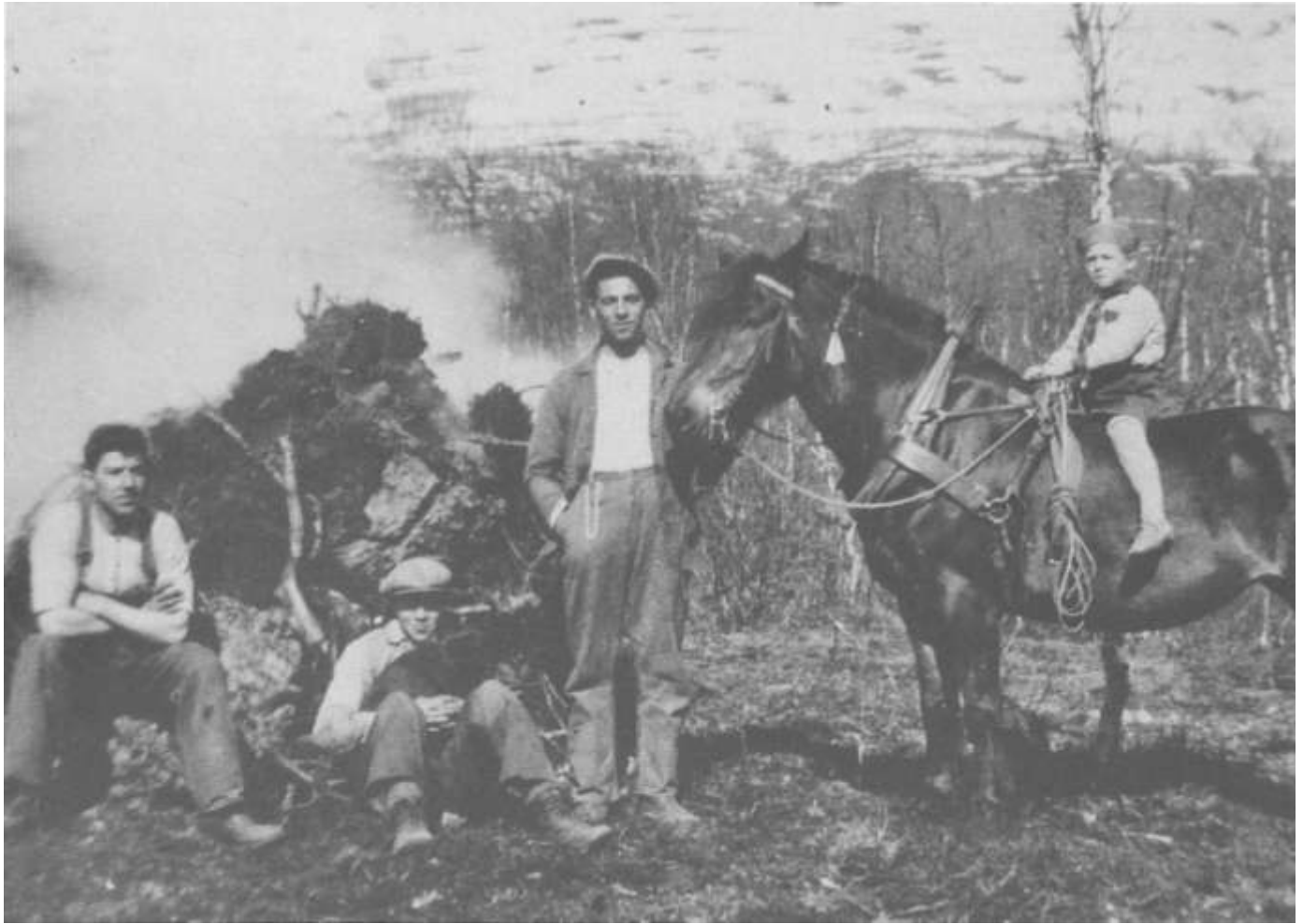
Nybrottsarbeide på Finnfjordeidet ca. 1933.
