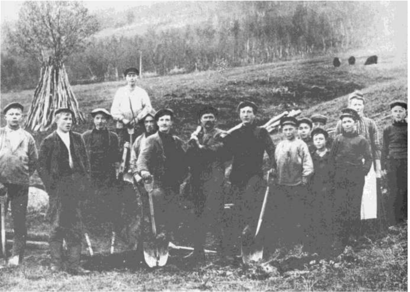
Arbeidslag på vegarbeid ved Osan i Rossfjordstrømmen, ca. 1912.
