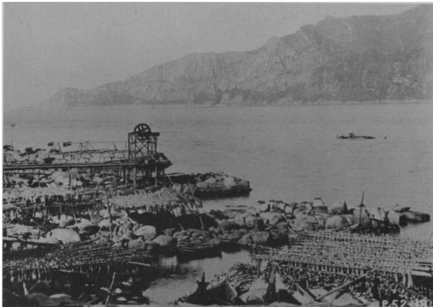
Støanlegg i Øyfjordvær 1897. Se bind I, side 12.
