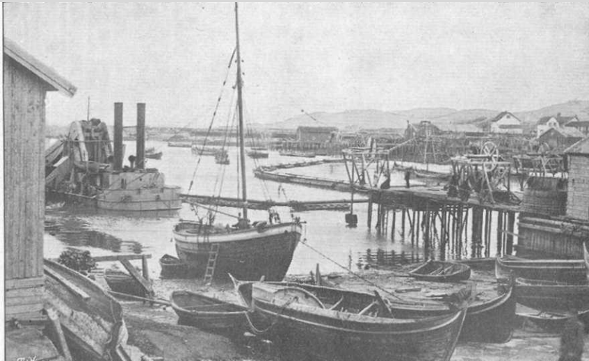
M/A Suggen arbejder i Berlevaag med pumpeledning for at føre de opmudrede masser paa land.
